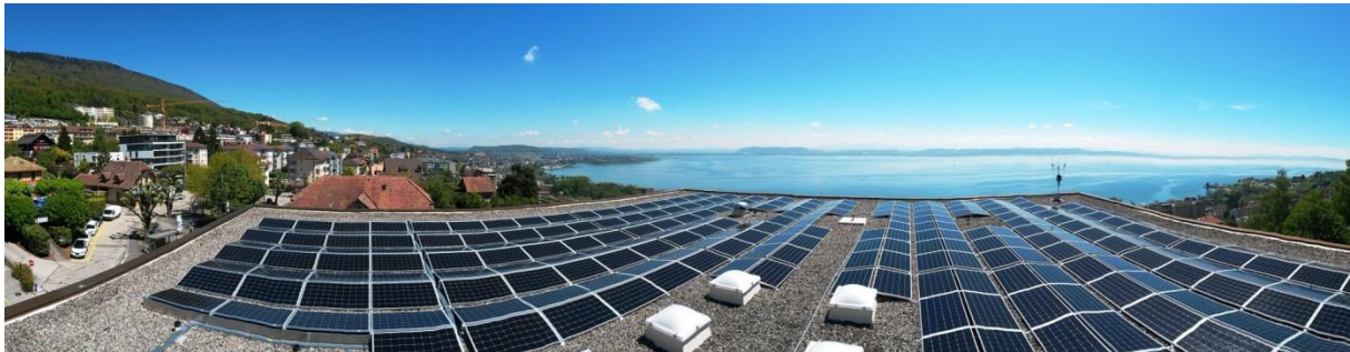
Installation de 100.3 kWc de Coopsol à la Coudre, Neuchâtel
