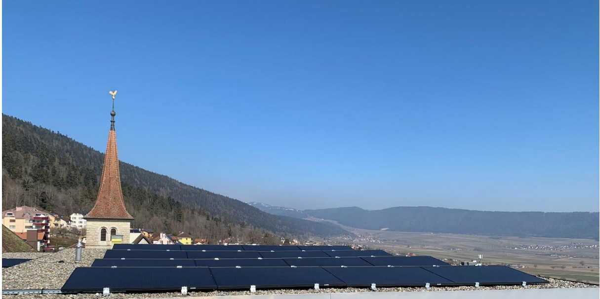
La centrale photovoltaïque participative sur le collège de Fontainemelon (264 panneaux, 100 kilowatts de puissance)
