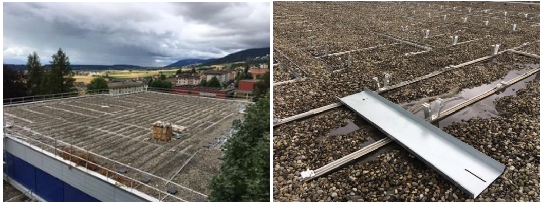
Photo 2 : Couloirs de gravier sur le bâtiment A ; photo 3 : bac de lestage
